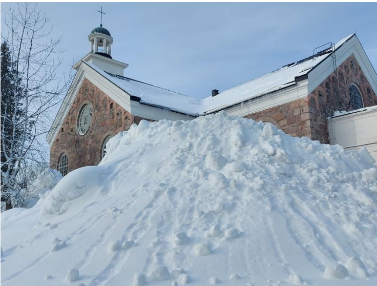
Lumityöt ovat yksi olennainen osa kiinteistöhuollon tehtäviä. Lumipäivystäjä huolehtii, että tilaan on turvallista saapua
