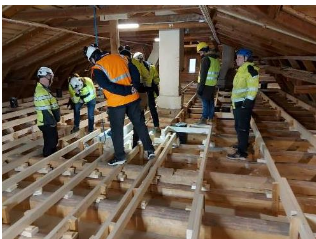
Yläpohja on puhdistettu, vuorossa uusien rakenteiden tutkinta
